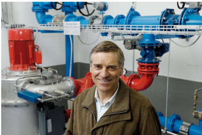
Werner Gamper, Betriebsleiter der Gas- und Wasserversorgung Richterswil, hegte schon lange die Idee «Trinkwasser als Energiequelle». Die Aufgabenstellung erwies sich jedoch als knifflig.
