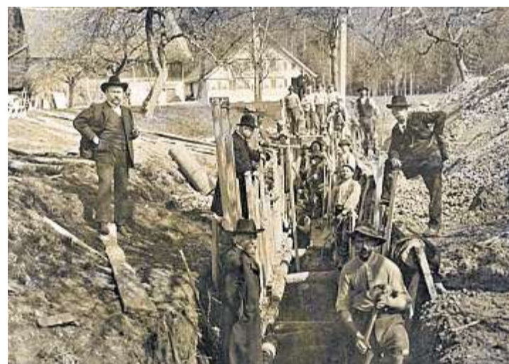
In der Tägerenau wurde 1909 eine zweite Quelfassung gebaut.
