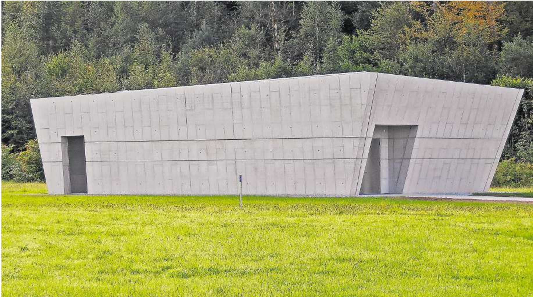
Das neue Grundwasserpumpwerk in der Tägerenau soll mit seinem Schrägdach zum Nachdenken und zum Diskutieren anregen. Der Neubau wurde in den letzten anderthalb Jahren gebaut und wird heute Abend in Betrieb genommen.
